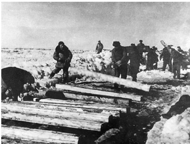
Budování železnice vězni gulagu
