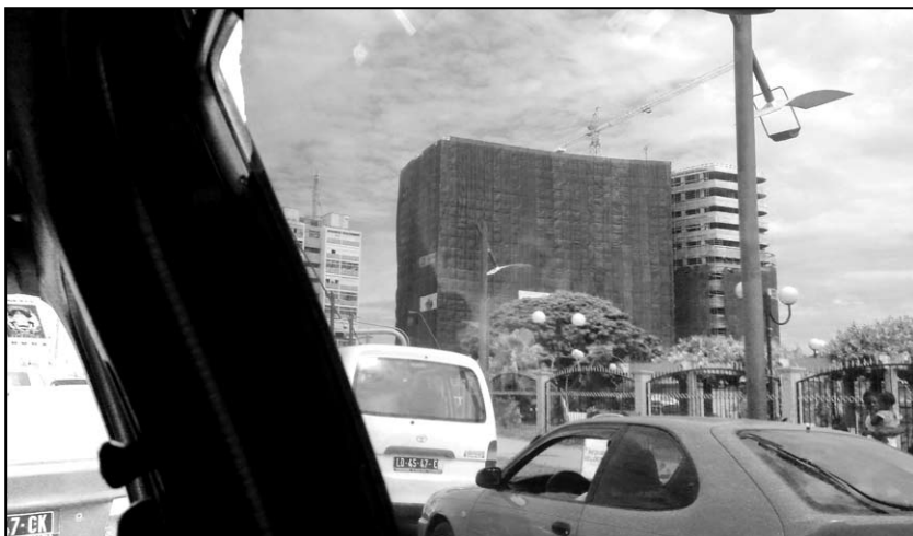
▲ Stavba a zácpa v dopravě u centra
